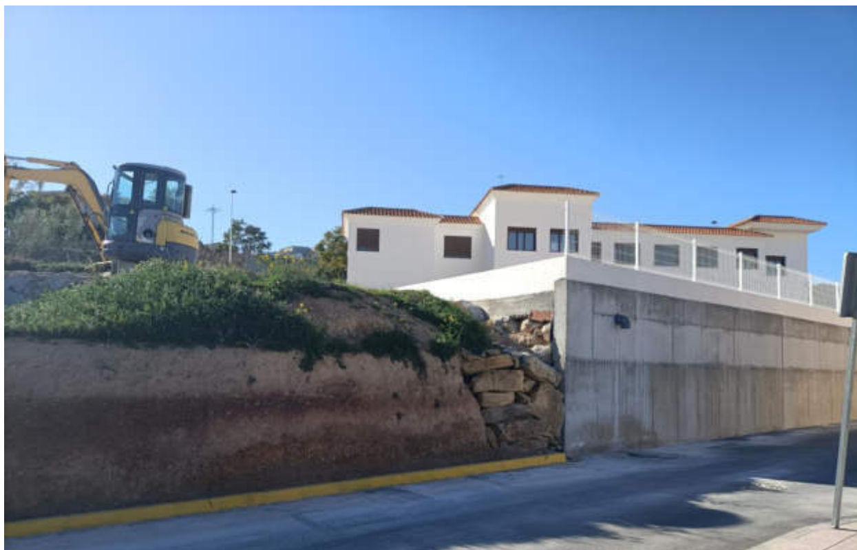
VISTA DESDE EL VIAL INFERIOR DEL ESPACIO LIBRE URBANIZADO
