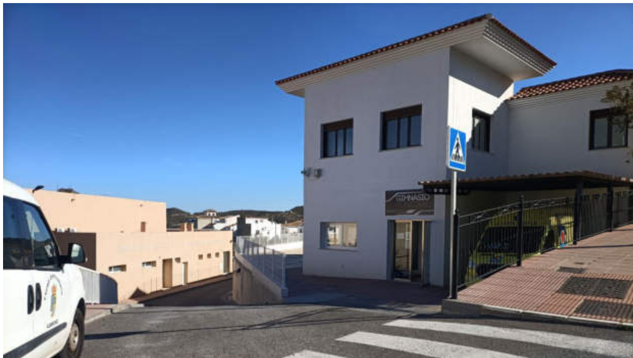
ACCESO A ESPACIO LIBRE DESDE ESQUINA SUR OESTE DE LA PARCELA CATASTRAL 04004A003004890000QW
